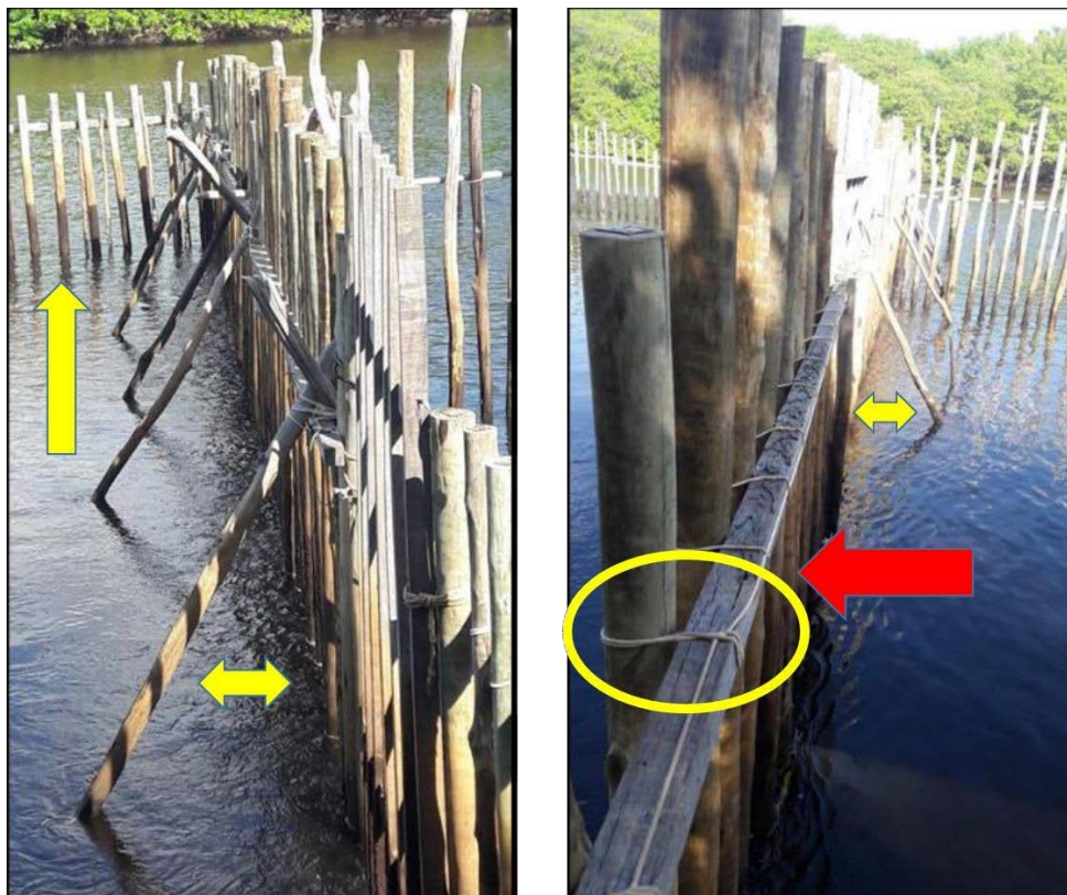
Figura 3. Exemplo de estrutura de Recinto de Aclimação com uso do madeiramento de eucalipto tratado em diferentes diâmetros e altura. As setas indicam as travas de apoio e a amarração em corda de seda resistente.
